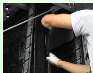
Запатентованный наполнитель BACross II для простоты осмотра и очистки
