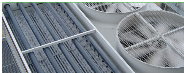
Полный доступ к системе оросительного распределения и верхушке теплообменника в процессе работы
